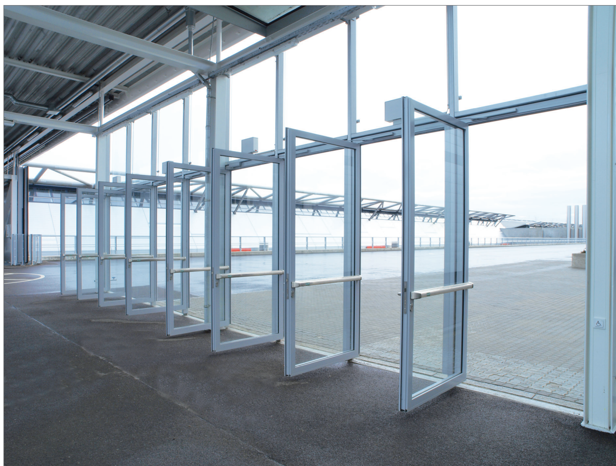
TS 5000 со скользящей шиной T-Stop, Выставочный центр в Штутгарте, Германия (фотограф Николаус Грюнвальд)
